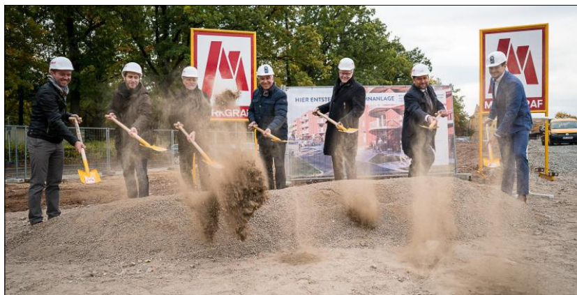
Wirbeln ordentlich Staub auf: die Beteiligten am Spatenstich um OB Thomas Ebersberger (Dritter von rechts) und den GBI-Aufsichtsratsvorsitzenden Markus Beugel (links daneben). Foto: Eric Waha
